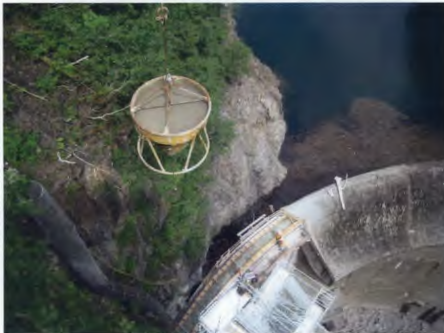
Figure 5: Keyway Concrete Pour
